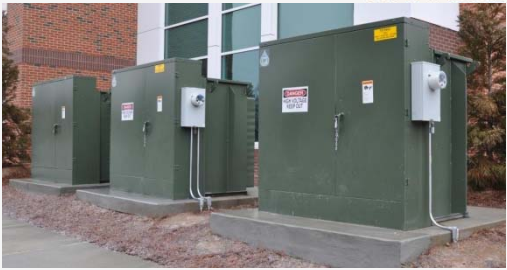
MV SWITCHGEAR
