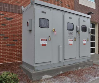
MV SWITCHGEAR
